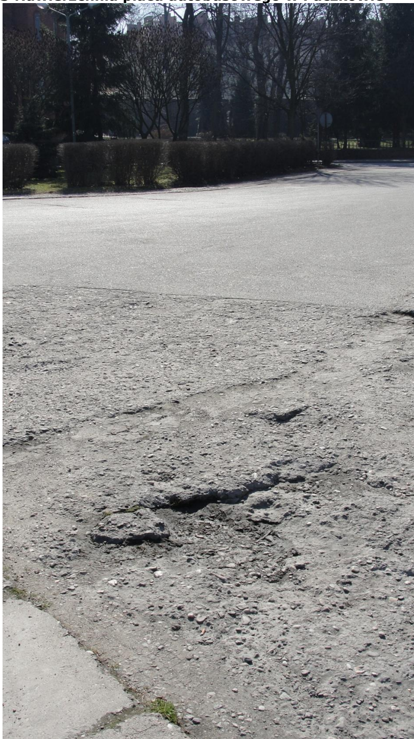
Rysunek 83 Nawierzchnia placu autobusowego w Paczkowie
